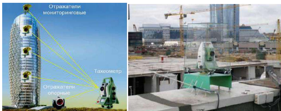
Рисунок 1 - Мониторинг здания с применением роботизированного тахеометра
